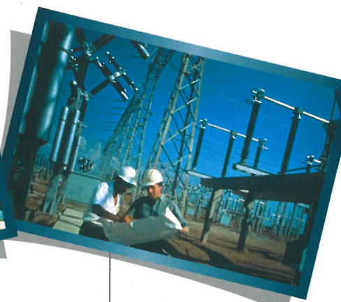
Energia Elétrica Electrical power
